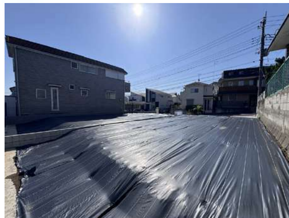
A区画（北西側より）
