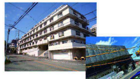
■大規模修繕工事中■
